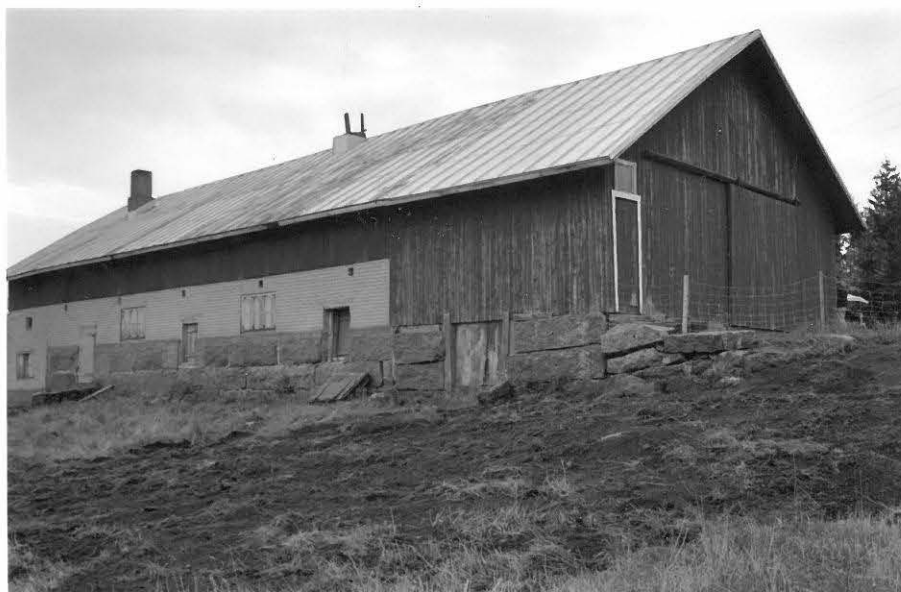
28. 118155 Yleiskuva navetan pohj. puolelta kairauksen jälkeen, etualalla alue 2, pohjoisesta.
