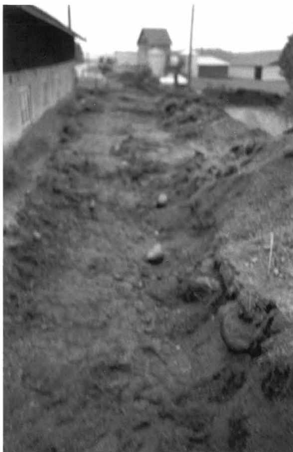
13, 118105 Alue 4, yleislevy maanpoiston jälkeen, luoteesta
