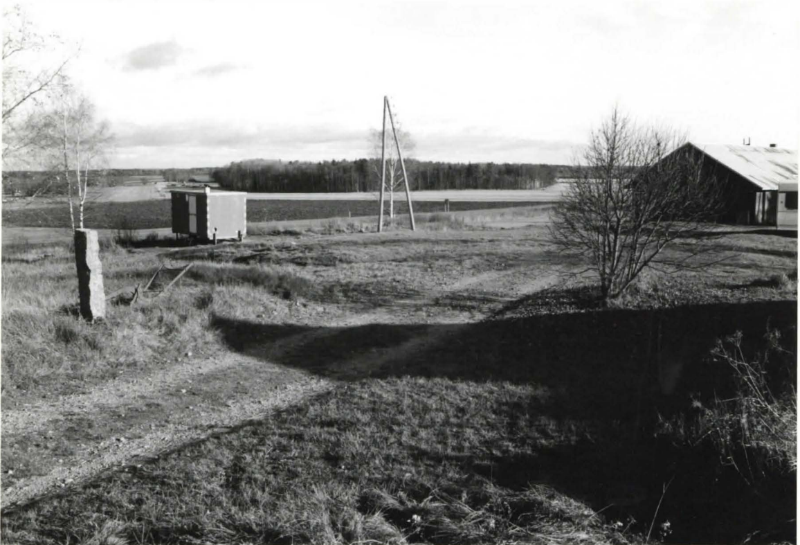
Kuva 4 (neg. nro 121809). Yleiskuva tutkimusalueesta tulevan opastuskeskuksen (kuvassa oikealla) pohjoispuolella. Kuvattu luoteesta.
