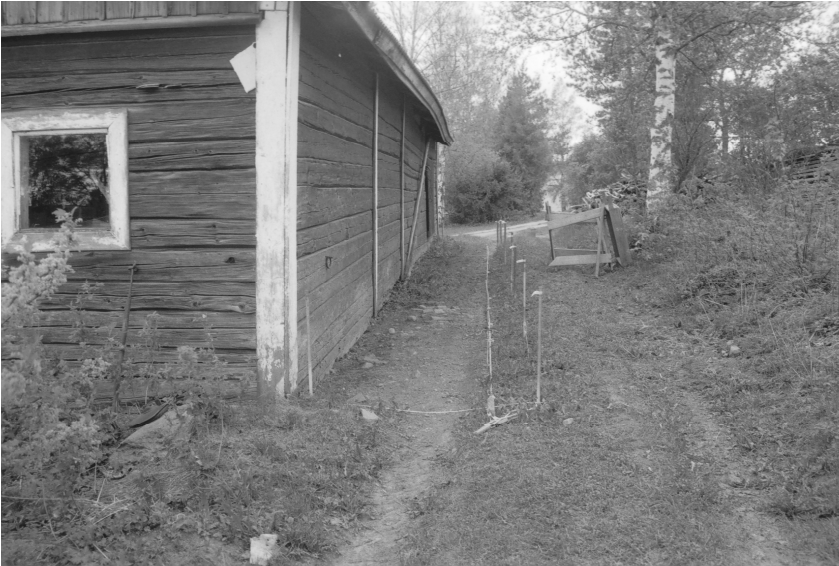
F145399:10 kellarivaraston taustaa, koeja paalutettuna, kuvattu idästä
