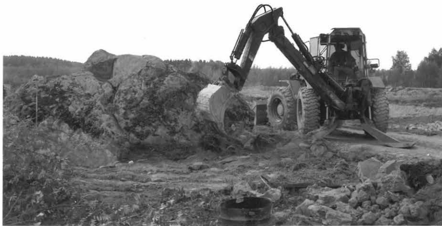
KUVA 3. KAIVINKONG POISTAA PINTAMAATA , KOILLISESTA
