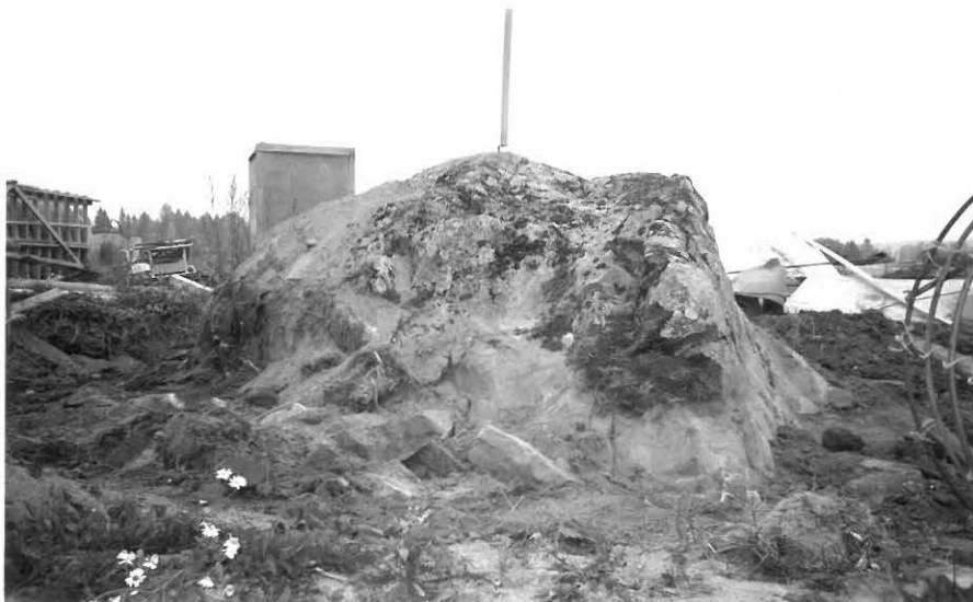
KUVA 20. R14 KAIVINKONEEN POISTETTUA PIINTAMAAN EDESSÄ NÄKYVÄ KIVENS PAIKALLE TUODUN IRTOMAAN SEASSA, LÄNNESTÄ. 113657
