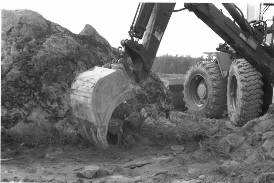
KUVA 4. KAIVINKONG POISTAA PINTAMAATA R13 PÖHJÄPUOLI , KOILLISESTA
