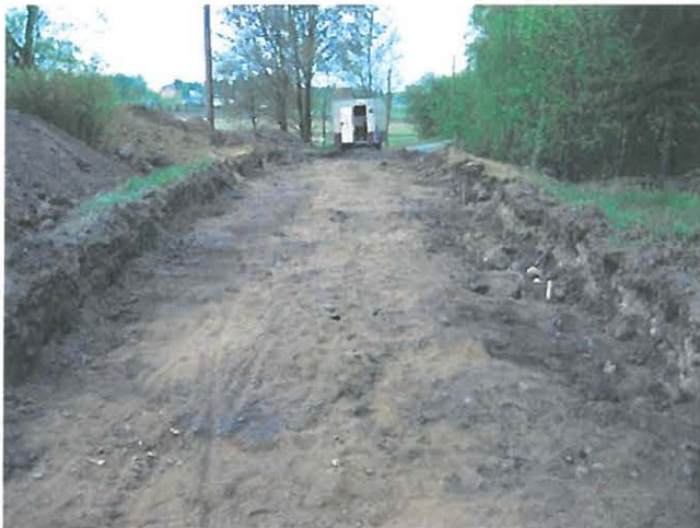
Kaivinkoneella avattu tieosuus, idästä.
