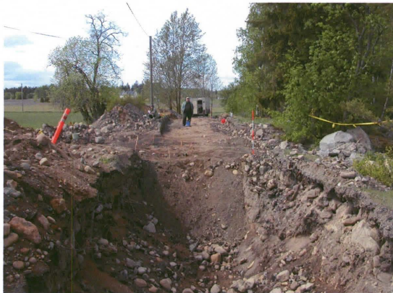
Lempäälä Aimalankangas. Kaivausalue pintamaan kuorimisen jälkeen. Etualalla viemärikaivanto. Yleiskuva. E.
