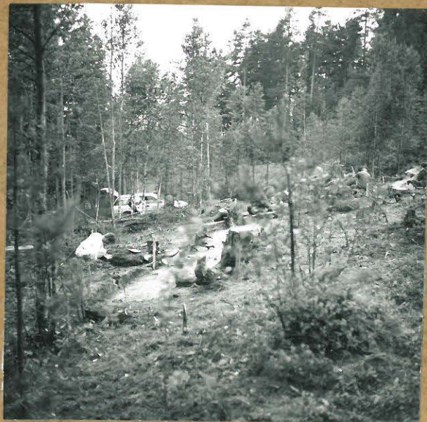
F. 79272 Työkuvaa. Koojia E-W Kaivetaan Kuvattu koillisesta
