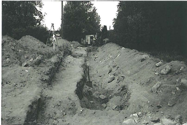
Pohjaan kaivettua kaivausaluetta tarkistetaan koneellisesti koejaa (koeja 1)kaivamalla.
