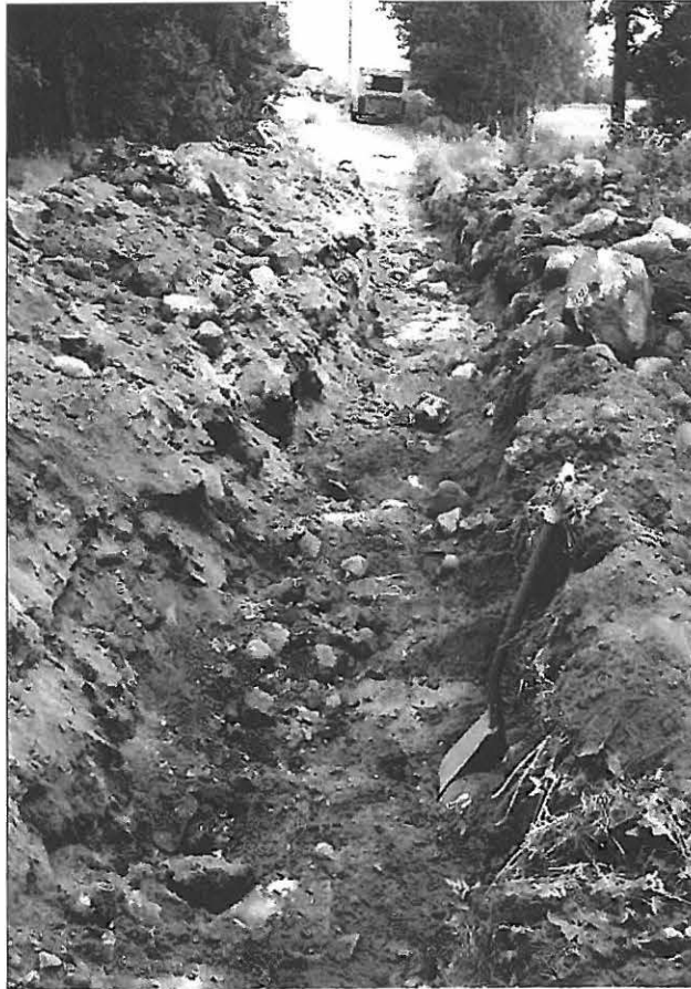
Tiekumpareeseen kaivettua koejaa.
