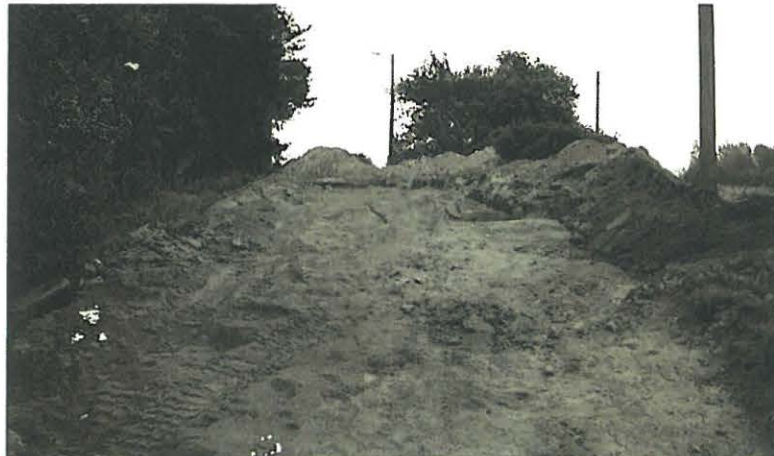
Lempäälä Aimalankangas, pelastuskaivausalue 2 pohjaan kaivettuna ja leikkauksen kiveys peitettynä.
