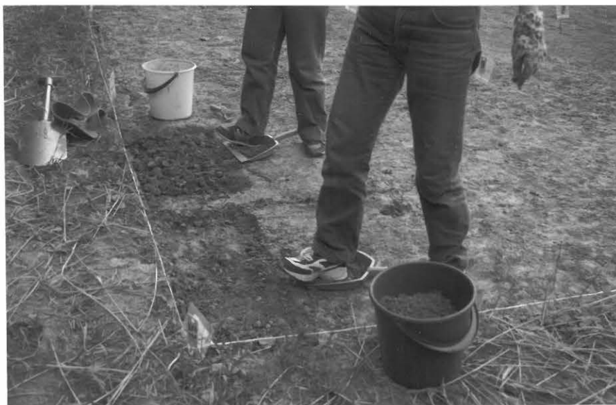
Kuva 18. Työkuva: savipaakkuja möyhennetään jaloin. (f. 130624)
