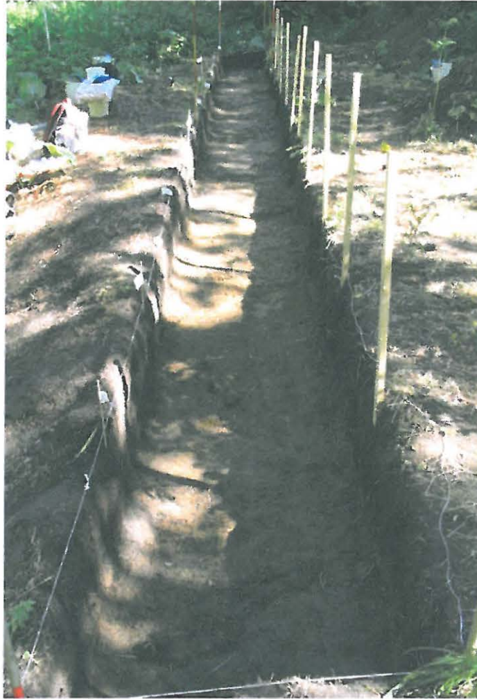
Kuva 3. Koeoja, taso 0. Multakerros poistettu. Kuvattu etelästä.
