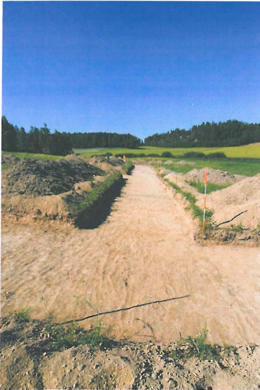
Putkilinjan suuntainen koeoja pohjaan kaivettuna.
