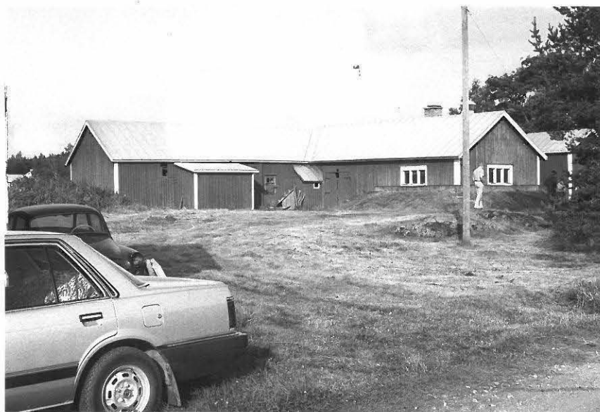
Kuppikallio sähköpylvään kohdalla. f. 136042
