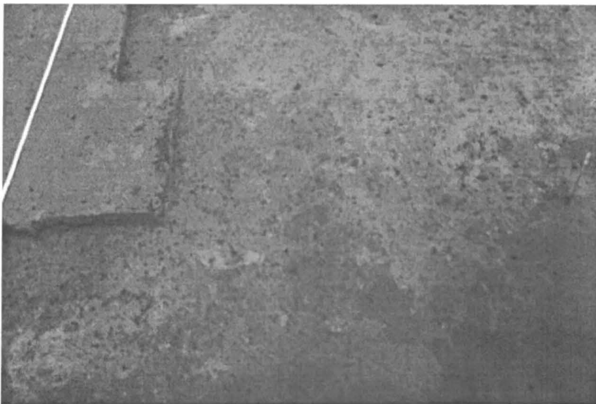
157. Alue 6, taso 6, 5046-47/29986-87, yleiskuva N kohden.
