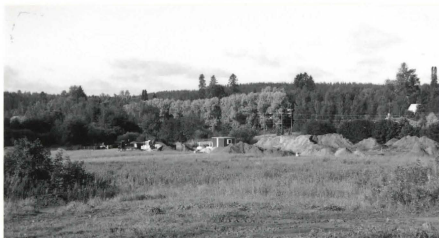
117759 Rakennussuunnitelma-alueen eteläosan työmaa. Pohjoisesta. Kuvannut Katja Vuoristo.
