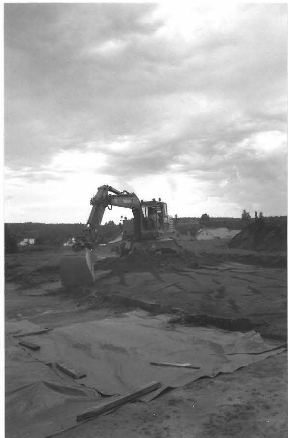
Neg.nro 125683 Työkuva. Peltomultaa poistetaan kaivinkoneella. Koillisesta. Kuva K. Vuoristo
