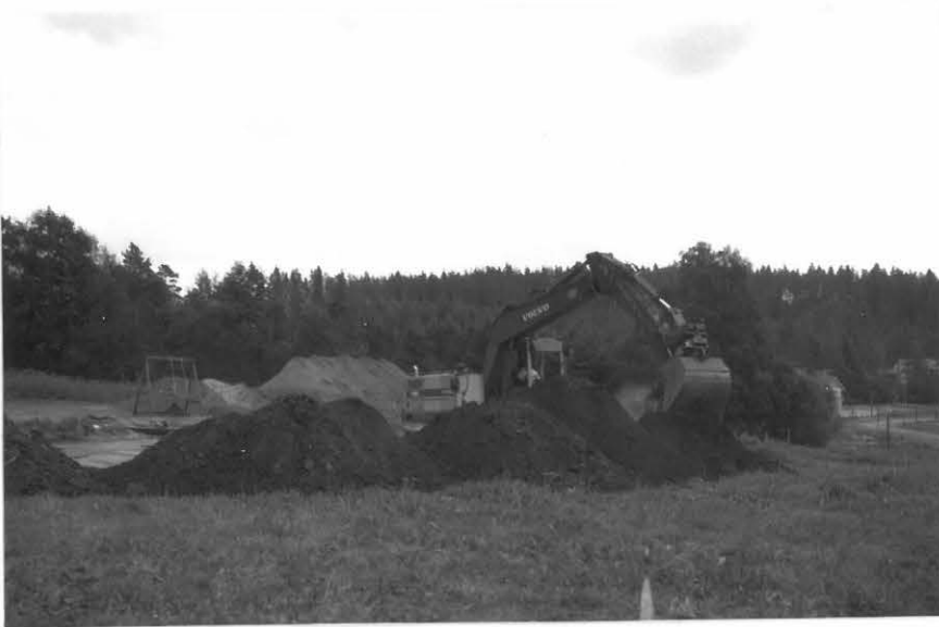
Neg.nro 125680 5 Työkuva. Karilantien länsipuoli, peltomultaa poistetaan kaivinkoneella. Luoteesta. Kuva K. Vuoristo
