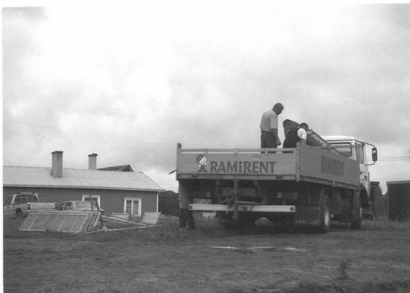
Neg.nro 125693 Työkuva. Valokuvaustornia tuodaan paikalle. Kaakosta. Kuva K. Vuoristo
