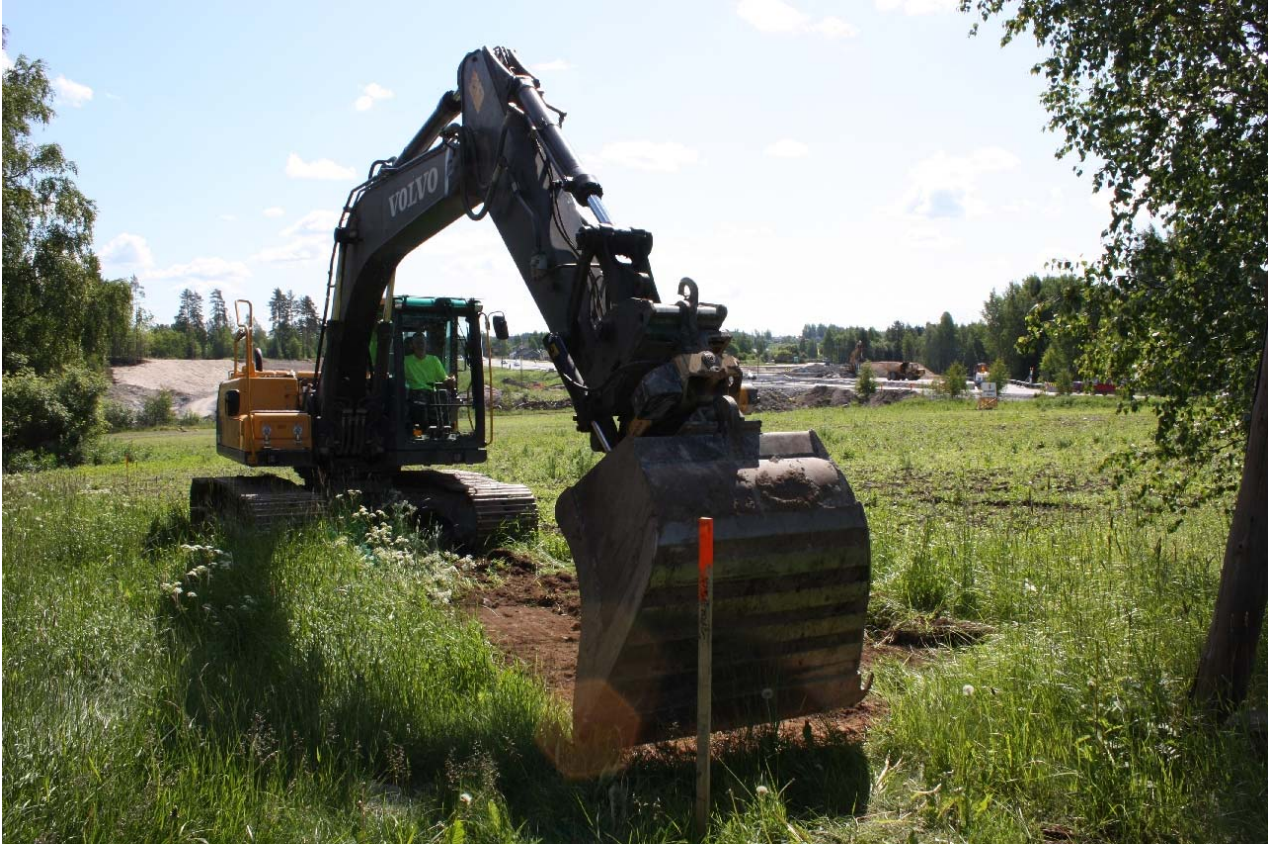
DG 667:1. Peltoa kuoritaan kaivinkoneella, luoteesta. Ensimmäiset kauhaisut 22.6.2009.
