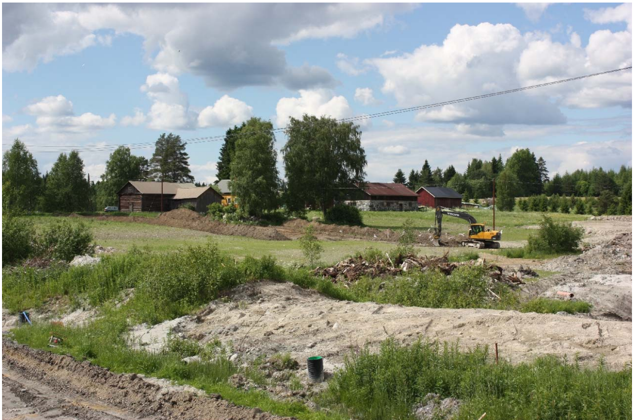
DG 667:8. Kaivinkone kuorii peltomultaa tulevalla tutkimusalueella Mikkelin Visulahden Harjussa
