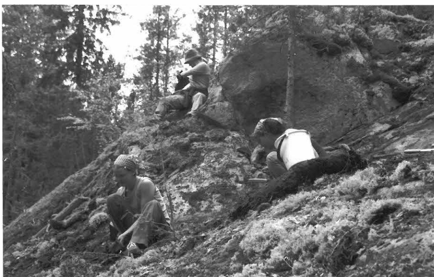
f 124805 Alempaa kvartsisuonta puhdistetaan. Idästä.
