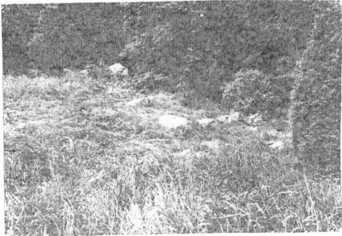
Kuva TYA 9542. Kaivausalue I ennen paalutusta. S.
