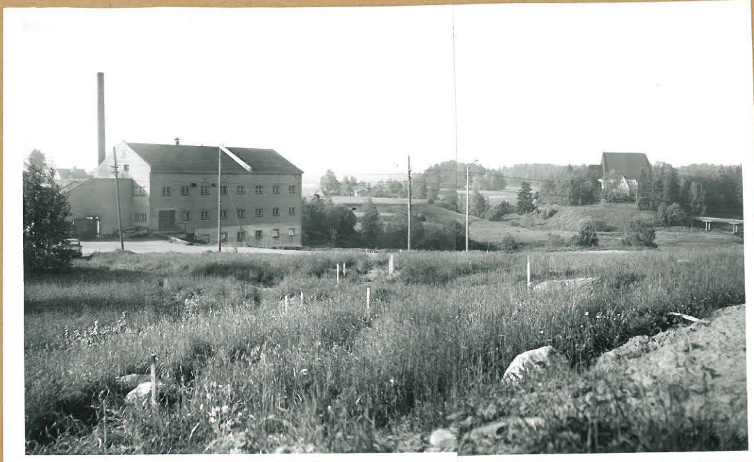
K.1 YLEISKUVA KOEKAIVAUSALUEELLE, TAUSTALLA VASEMMALLA MYLÄYRÄKENTTÄ JA NOUSIAINEN KIRKKO OIKEALLA HIRVIJÖEN ETELÄPUOLELLA, KUV. KOHTI KAAKKO-ETELÄÄ, PAALUJALAN TIELINURTU KOHDALLA. EDESSÄ TÄNTEMÄKISÄÄ,
