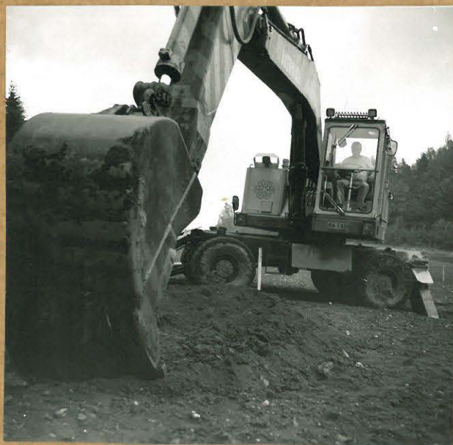
F 73923 Pinmaa poistettiin koneellisesti ruutujen 1688-98/1216-22 alueelta.
