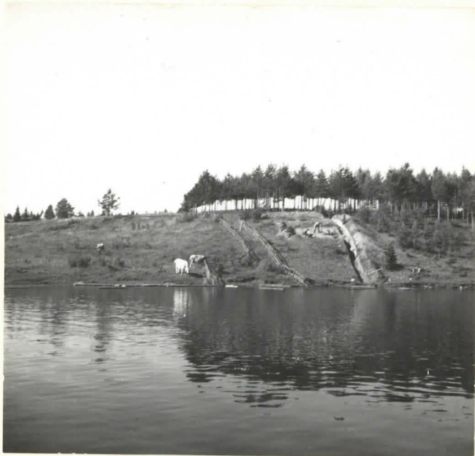
TUOKKILAN KAIVAUSPAIKKA VALOK. KOEIJAN SUUNNASSA JOELTA, NOIN KOILLISESTA.
