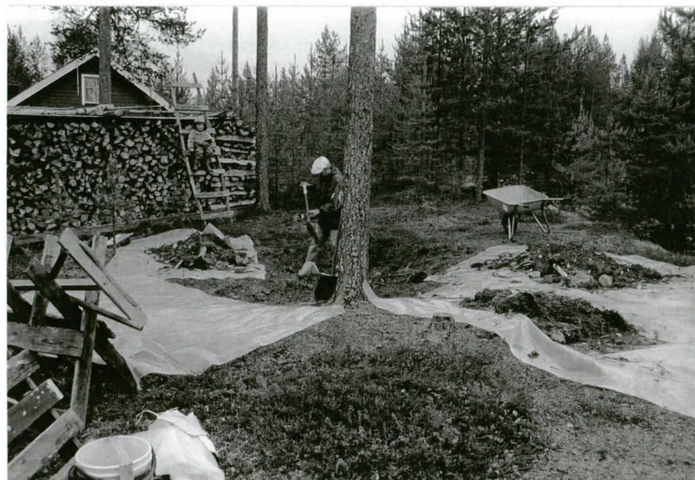
KUVA 5. Kuoppajäännettä tyhjennetään rakennusjätteestä. S.
