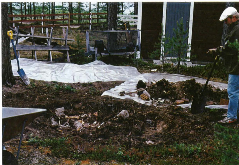
KUVA 8. Tutkimuskohdetta tyhjennetään rakennusjätteestä; tiiltä, muovia, vuorivillaa, betonia ... E
