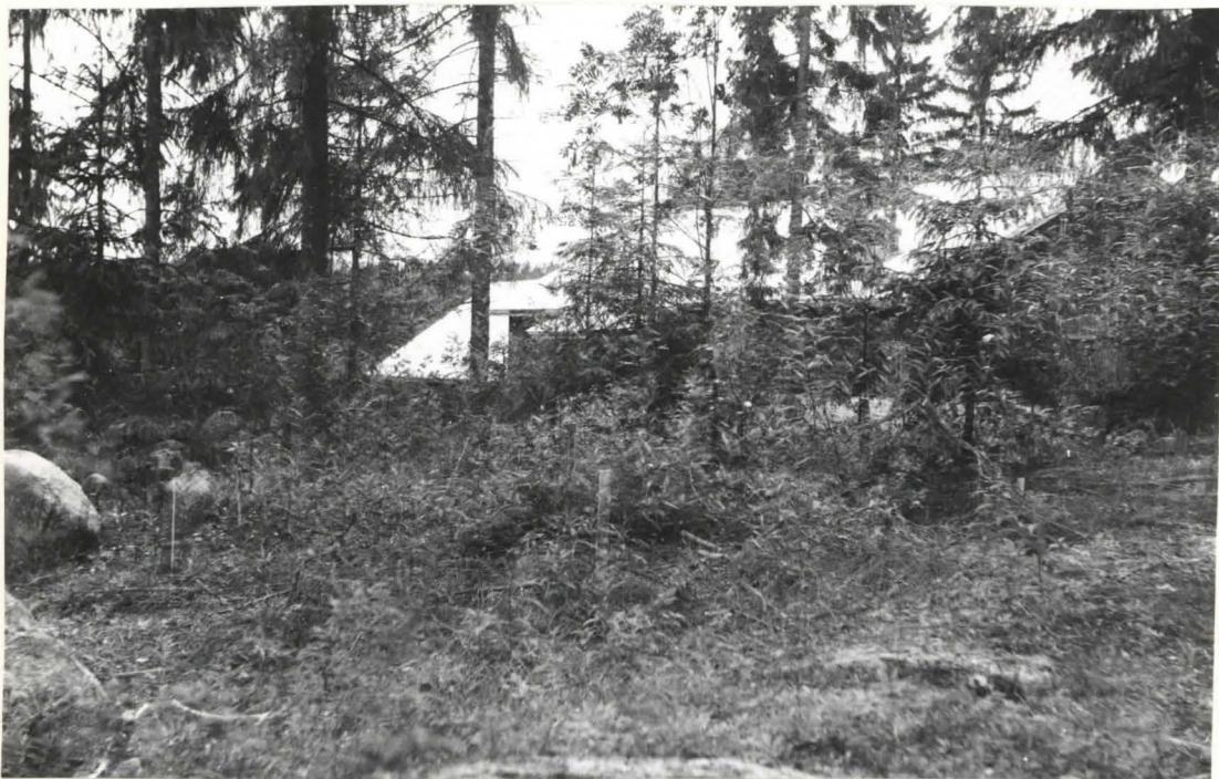
TYA 5299 Kaivanto A3 ennen töiden alkua. Kuvattu idästä.
