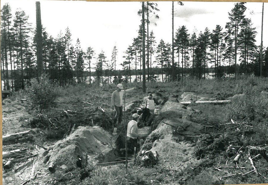
TASANNE JA KOE OJAN A3 IDÄSTÄ. ALUE A2 KESKELLÄ OLEVAN MÄNNYN KOHDALLA TASANTEEN RANNAN- PUOLEISELTA REUNALLA.
