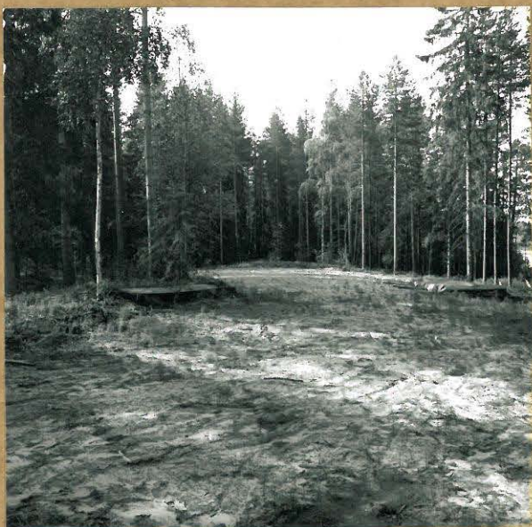
KUVA 3. F 707822 YLEISKUVA KESÄMÖKIN RAKENNUSPAIKASTA, KUVATTU PÖHJOISESTÄ.
