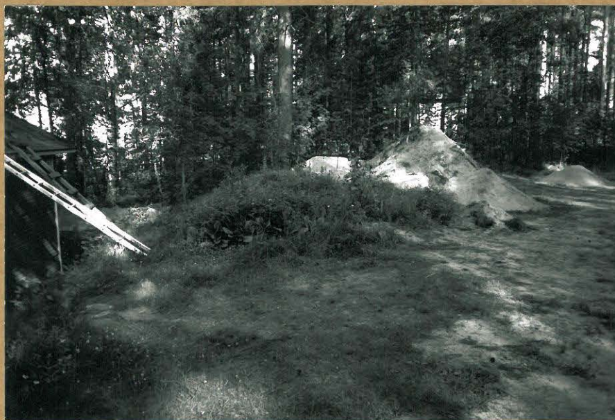
KUVA 7 F. 107848 UUDEN KESÄMÖKIN RAKENNUSPAIKKA, KUVATTU KAAKOSTA.
