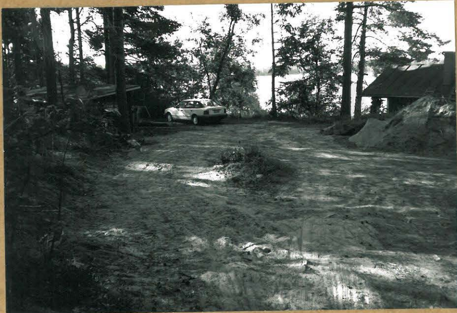
KUVA 5 F. 107846 UUDEN KESÄMÖKIN RAKENNUSPAIKKA, TAUSTALLA ALVAJÄRVI, KUVATTU POHJOISESTA.
