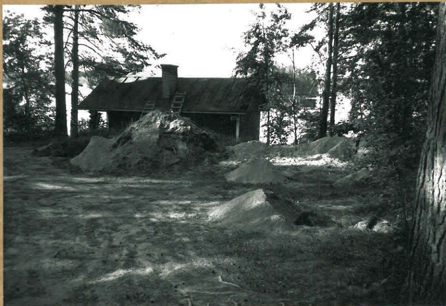
KUVA 6 F. 107847 UUDEN KESÄMÖKIN RAKENNUSPAIKKA, TAUSTALLA ALVAJÄRVI, KUVATTU POHJOISLUVOTEGSTA.
