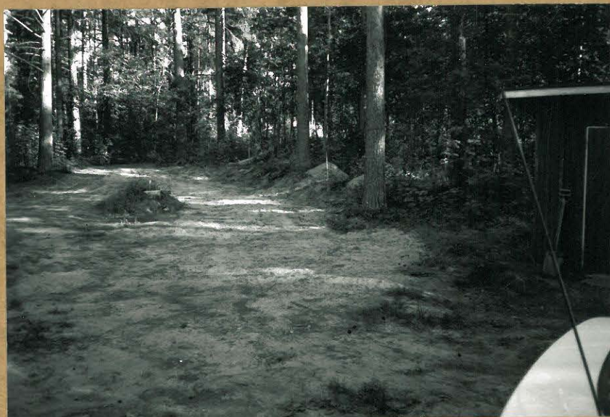
KUVA 9 F. 107850 UUDEN KESÄMÖKIN RAKENNUSPAIKKA, KUVATTU ETELÄSTÄ.
