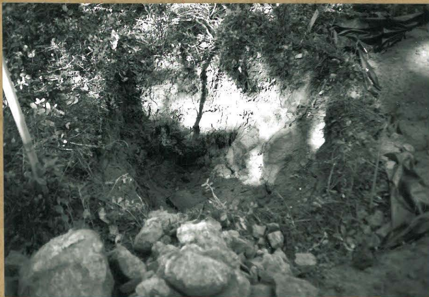
KUVA 4 RAKENNUSPAIKAN KOEKUOPPA, KUVATTU IDÄSTÄ.
