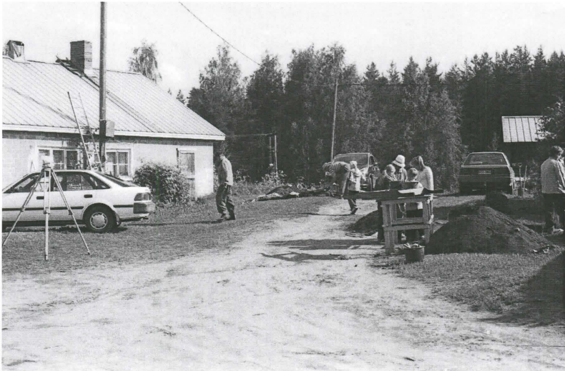
Yleiskuva pihalta, tien vieressä vas. alue D, oikealla alueen C kaivaus käynnissä, koilliseen kuvattu
