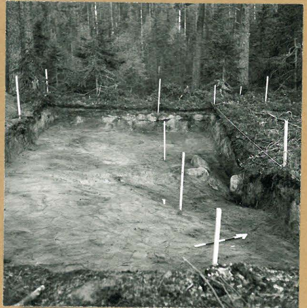
Kuva 22. Sama, taso 4. SE-NW F.67338
