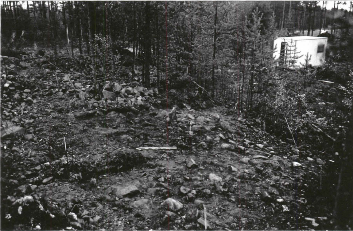
5. Koe 11, turpeen ja pintamaan poiston jälkeen.
