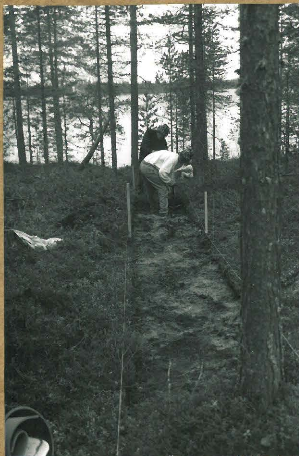
f 86073 K. J4. Työmaa, koesija 10 turulta pisteeseen, lsv. länteen
