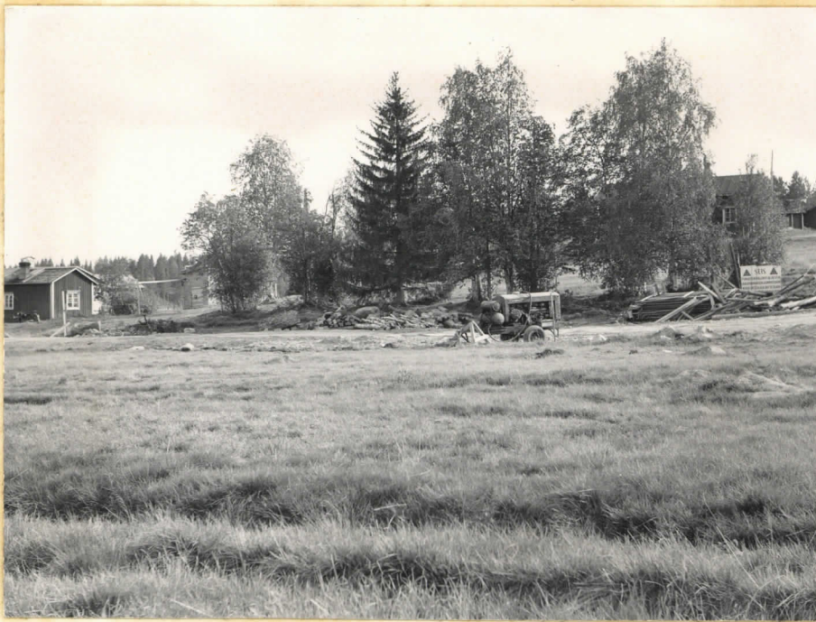
Kaivausalue tutkimusten jälkeen täytel- tyinä. Kuvattu luoteesta.
