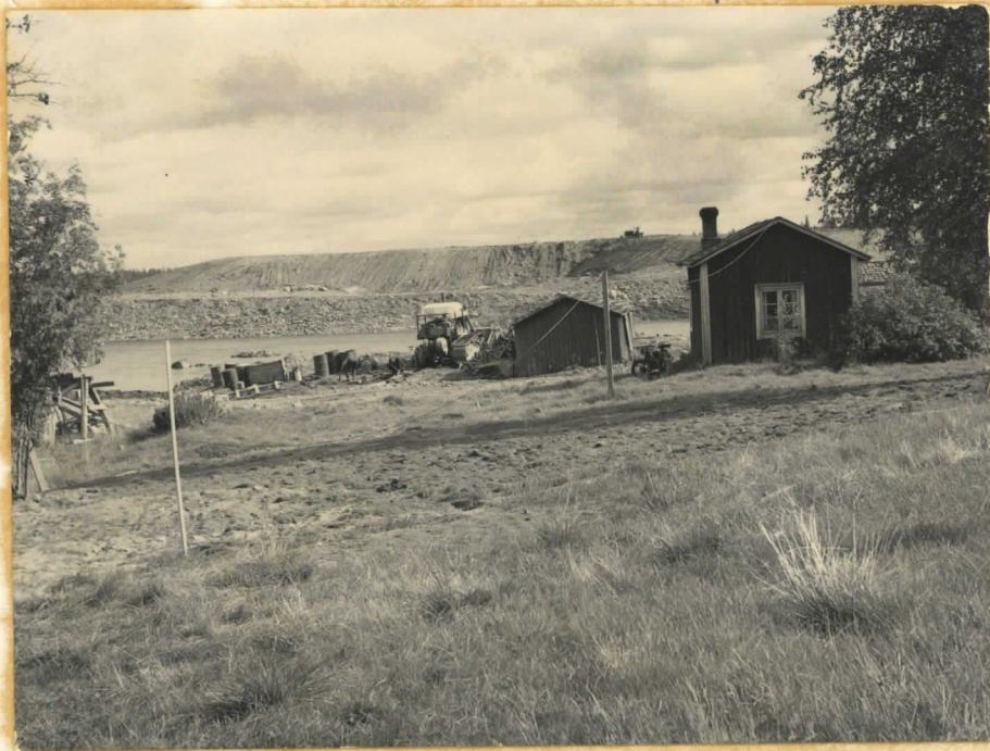
Kaivausaluetta tutkimusten jälkeen täytettynä. Kuvattu lännestä.
