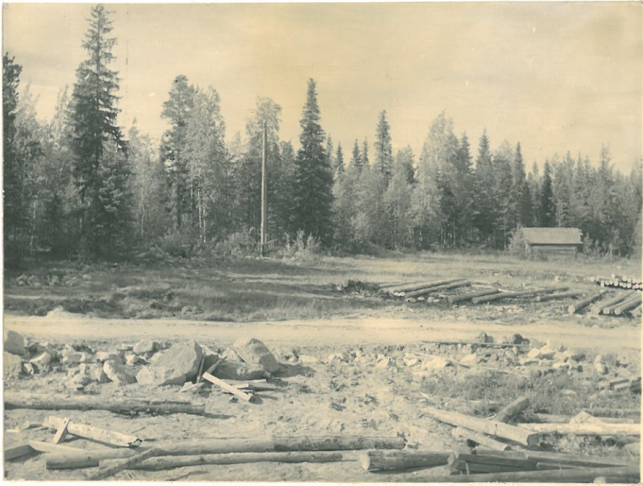
Siikaniemi 6. Tien takana tukkipuitten pätre kaivettu kooja näkyv. mullakanana. Oja aloitettiin pellon ja metsän rajalta ja lopetettiin lähelle tietä - etelästä kuvattuna.
