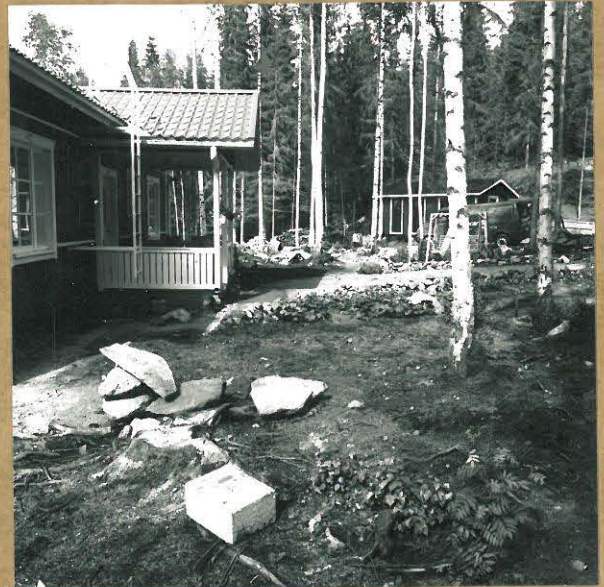
KUVA 48. F. 103607 RÖYKKIÖ 3 KAIVAUKSEN JA MAAN- TASAUKSEN JÄLKEEN, KUVATTU LOUNAESTA.
