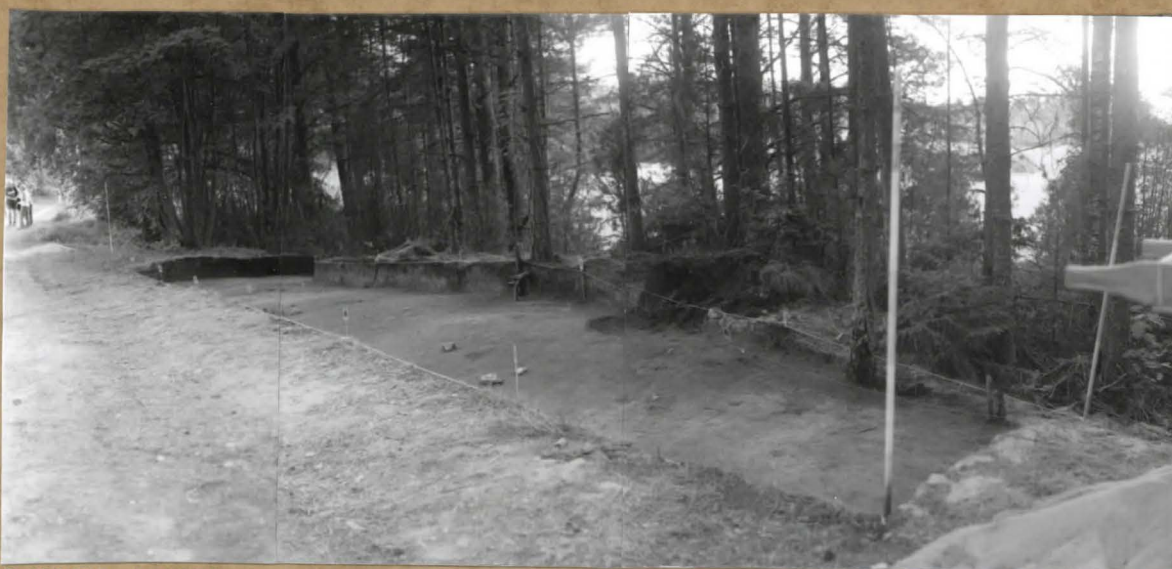
F 108 830 - 108 832 KAIVAUSALUE II TASOSSA 4. KUVATTU LUOTTEESTA.
