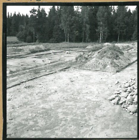
YLEISKUVA KAINAUKSEN PÄÄTTYTTYÄ, SE
