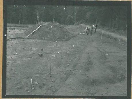
YLEISKUVA ITÄISESTÄ KAIVAUSSALVEESTA, TASO 0, S
