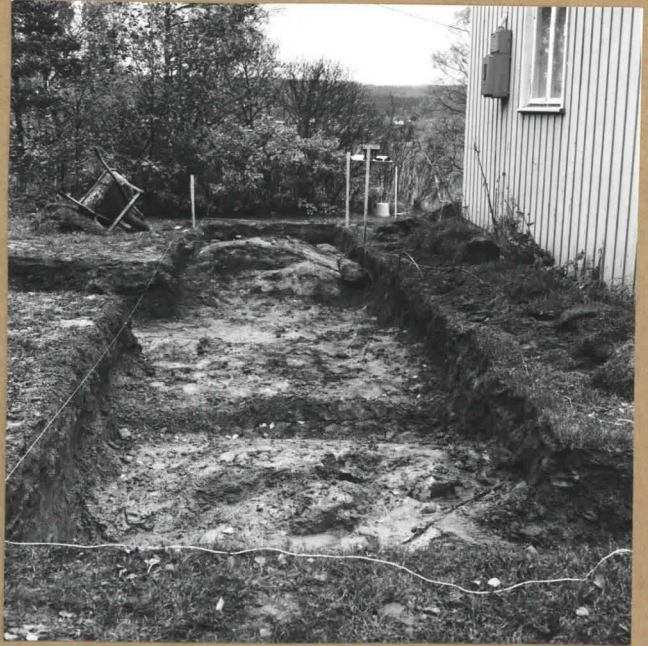
K.5 KOEON PURETTAVAN RAKENNUKSEN 58322 KOILLISPUOLELTA KAIVETTU POTKIAAN, KUV. ITÄKAARKOON
