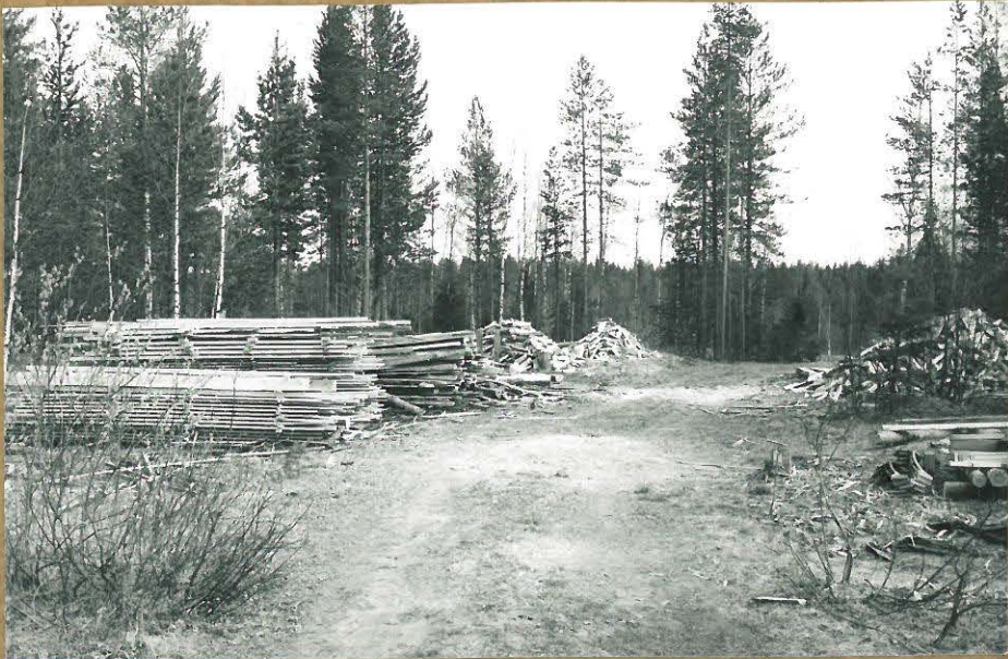
f: 83251 Kuva 1 Yleiskuva E-alueesta ennen raivausta. SSE-NW.
