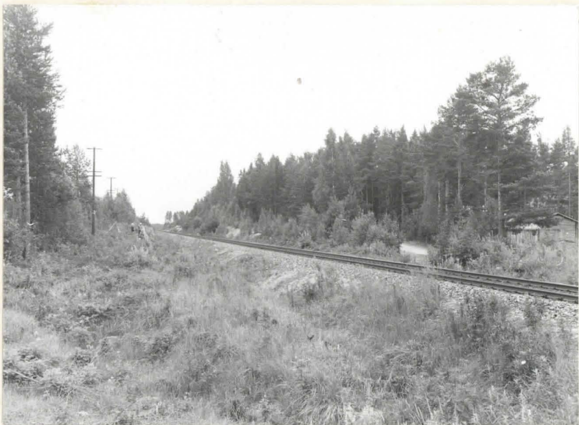
1. RAIVAUSALUE NVOLTEN OSOITTAMALLA KONDALLA. KUVA LUOTTESTA F.A. 1020
