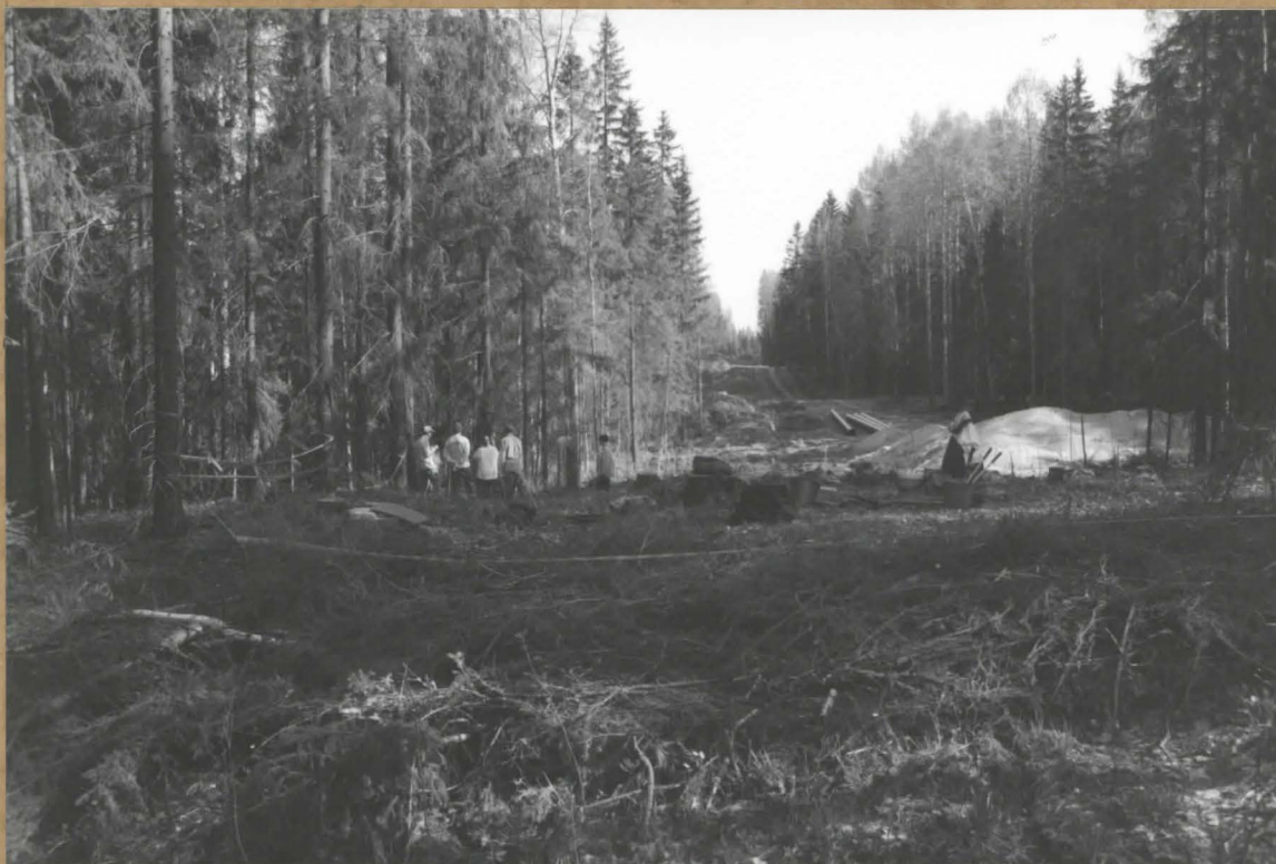
Kuva 1. Yleiskuva kaivausalueesta. Taustalla pohjoiseen 110615 jatkuvaa maakaasulinjaa. Etelästä.
