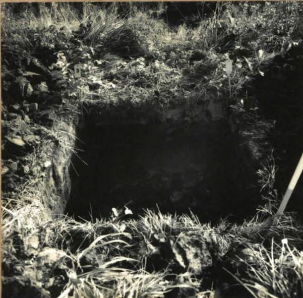
KUVA 4. F 107857 RAKENNUKSIKON MAAPERÄ ON SAVEA, KUVATUN LÖUNAASTA.
