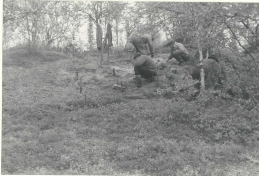
Kaivaus meneillään, kuvattu rinteen alapäästä, etelälounaasta
