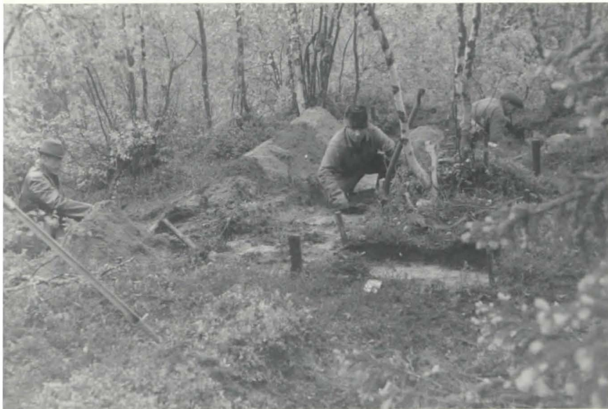
Kaivaus käynnissä, kuvattu kaakosta
