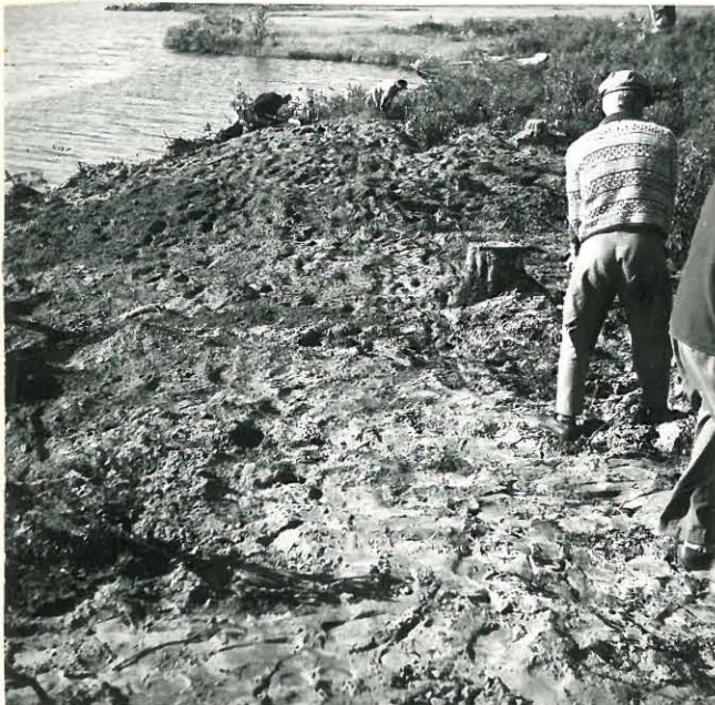
Kuva 13 Eteläpuoli kaivausalueesta täytettäessä. Kuvattu pohjoisesta
