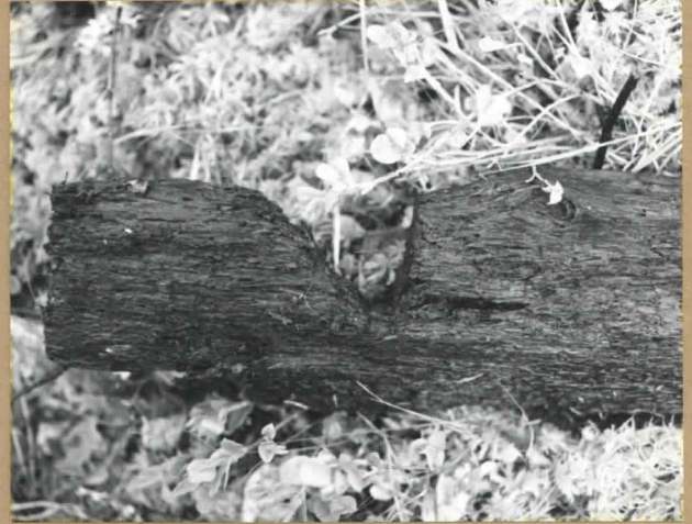
17 Kaivon päällä ollut hirsi, josta näkyy kaivossa käytetty salvo-tyyppi
