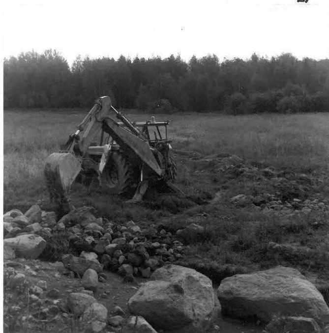
Kaivausaluetta täytetään. Kuvattu lounaasta F. 43922
