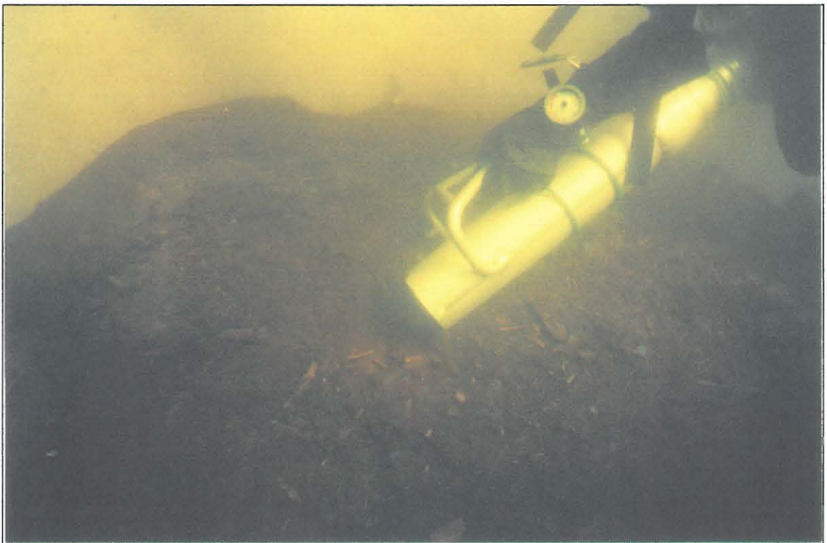
Kuva 2. Vedenalaista imurointia mammuttipumpulla.
