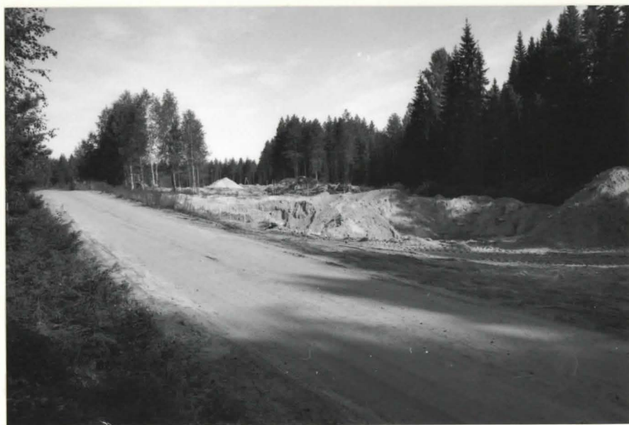
F. 136056 Tutkimusalueen eteläosaa, oikealla tien vieressä heinäkuussa aloitettu hiekanotto, etelästä
