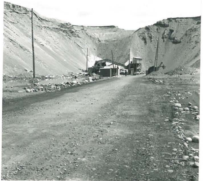
KUVA 19. HARJUA VIEDÄÄN, LÄNNESTÄ. TAUSTALLA KAIVAUSPAIKKA NOTKON KOHDALLA.
