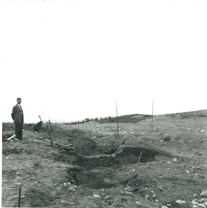
KUVA 36. YLEISKUVA IDÄSTÄ. HAUDAT 40 JA 39 TYÖN ALLA EDESSÄ; TAUSTALLA SAVIKUMPU, VASEMMALLA HARJANNIETTA.
