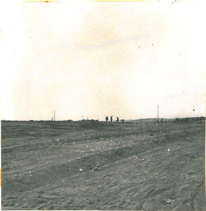
2485 K:23 VILUSENHARJU I:STÄ. KAIVAUS MENNEELLÄÄN
