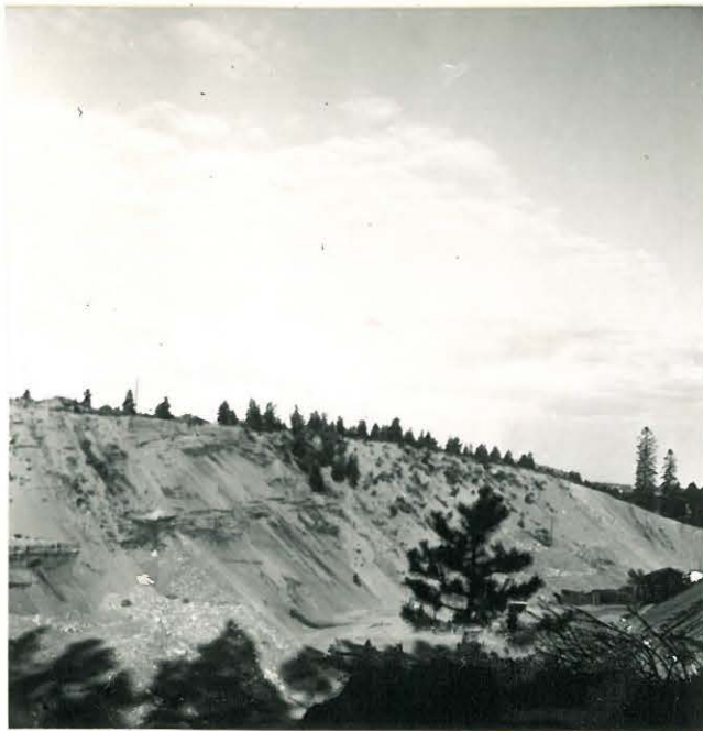
2485 K:12 VILUSENHARJU TVH:n KUOPPA LISTA. POLTETTUA LUUTA PENSASTUNEEN OSAN YLÄKU- PEESSA.
