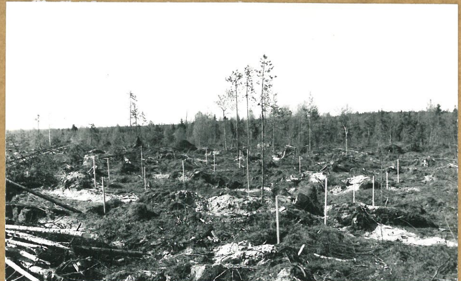
74167. KAIVAUSSALUE KOILLISESTA, PAALUTETTUNA JA RAINATTUNA.
