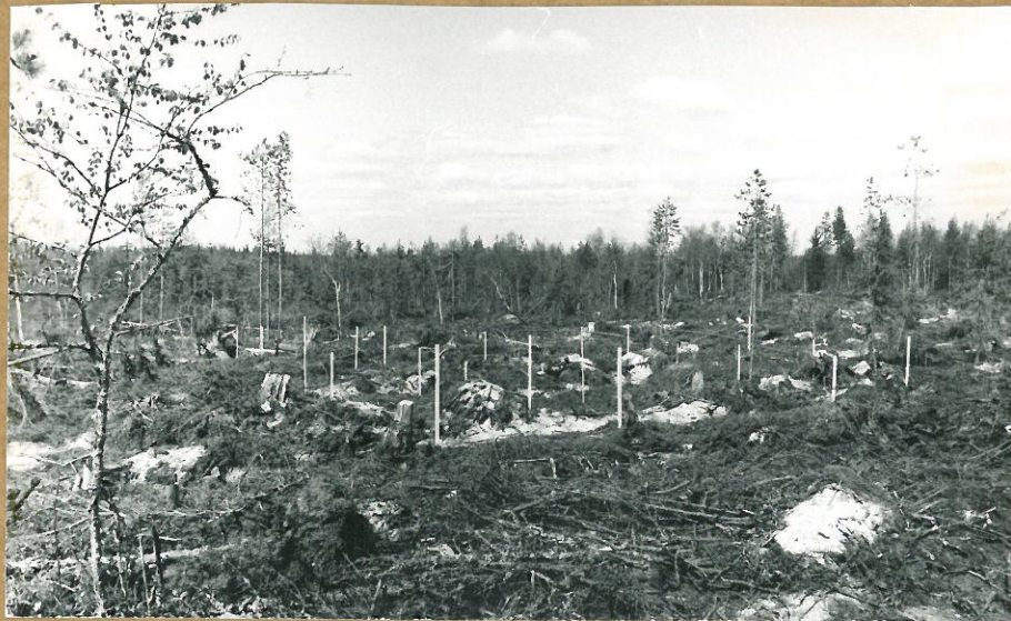
74166. KAIVAUSSALUE PAALUTETTUNA. LOUNAESTA.
